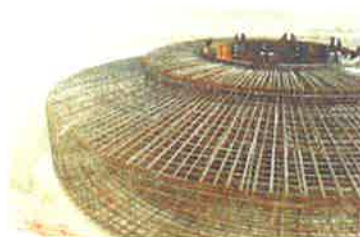
Photo 1 : Excavation et préparation de l'armature
