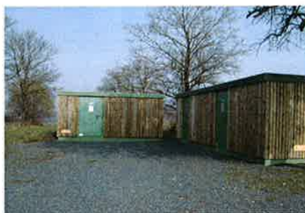
Photo 2 : postes de livraison – Parc éolien du Haut des Ailes (54)
